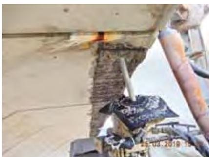
Betonabtrag am Kragarm außen mit Hochdruckwasserstrahl
