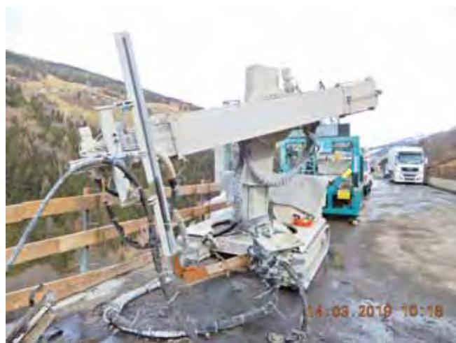
Roboter für Betonabtrag mit Hochdruckwasserstrahl
