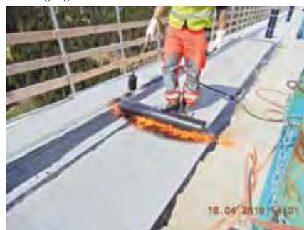
Aufflämmen der oberen Abdichtungslage
