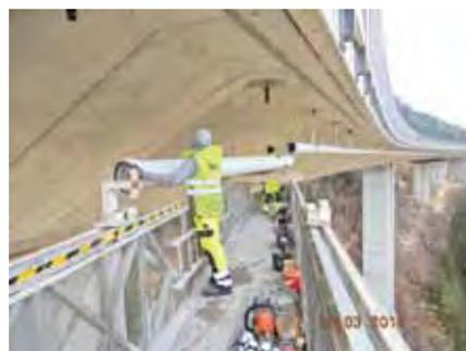
Montage der Entwässerungslängsleitung am Talübergang Krens
