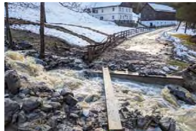
Durch die Wassermassen wurde diese Brücke im Leoben-graben weggerissen.
