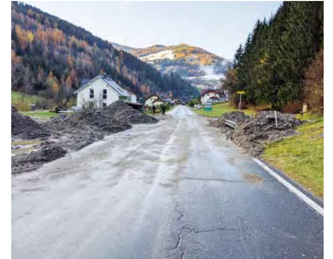
Aufgrund der großen Regenmengen verklebte sich das Kerschbaumerbachl und verlegte dadurch die B99 in Eisentratten.
