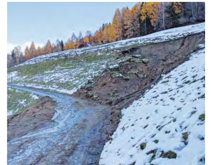
Ein Abbruch im Feld, dadurch wurde die Zufahrtsweg vermurt.
