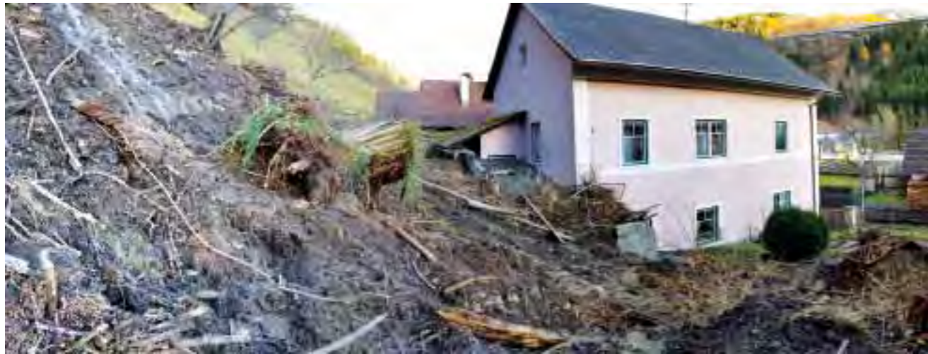
Der Hang hinter dem Gemeindeamt ist angebrochen und ist zum Teil abgerutscht.
