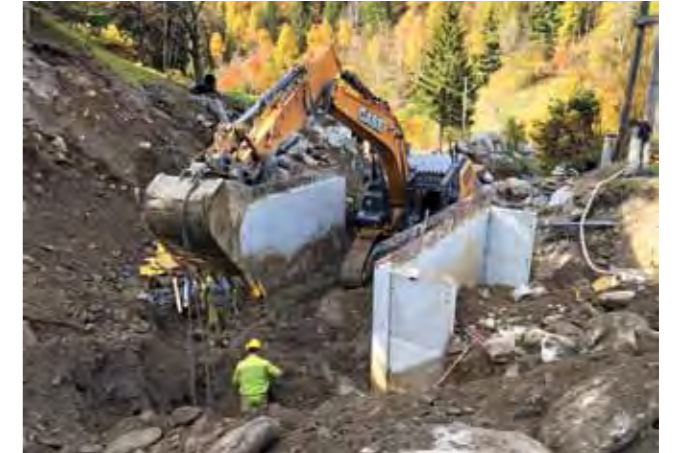
September 2019 (Baubeginn mit Errichtung des Zufahrtsweges und der Brücke).
