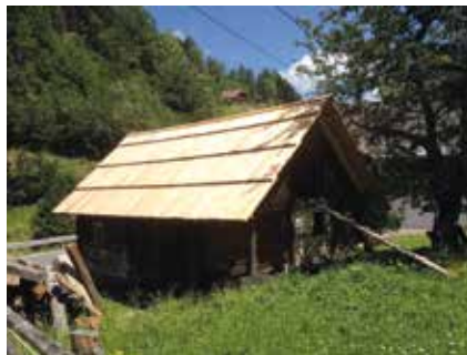
Holzdacheindeckung in Kremsbrücke
